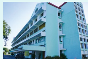
エンジニアリングビル(工学部)
